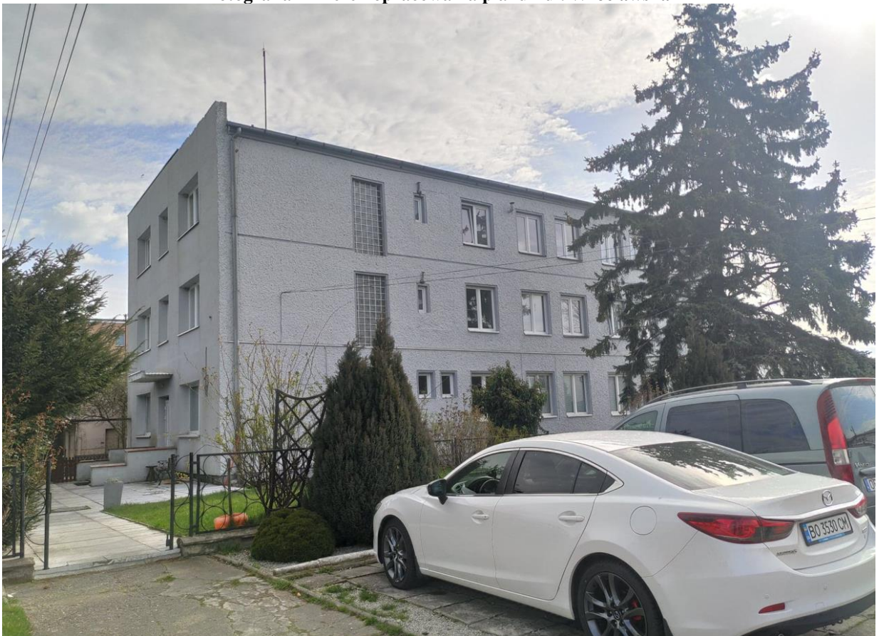
Fotografia 3 - Teren opracowania planu - zabudowa wielorodzinna
